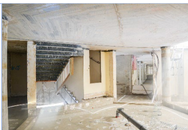
Travaux du hall principal: Automne 2025
