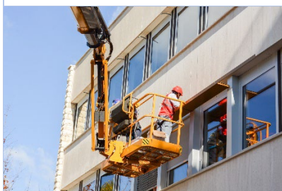
Pose des fenêtres: Automne 2025
