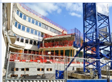
Construction de la future extension: Automne 2025
